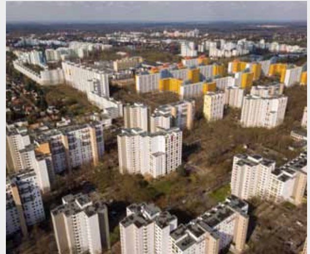
ABBILDUNG 7 Der Berliner Stadtteil Märkisches Viertel als Pilotquartier für eine assistierte Versorgung
